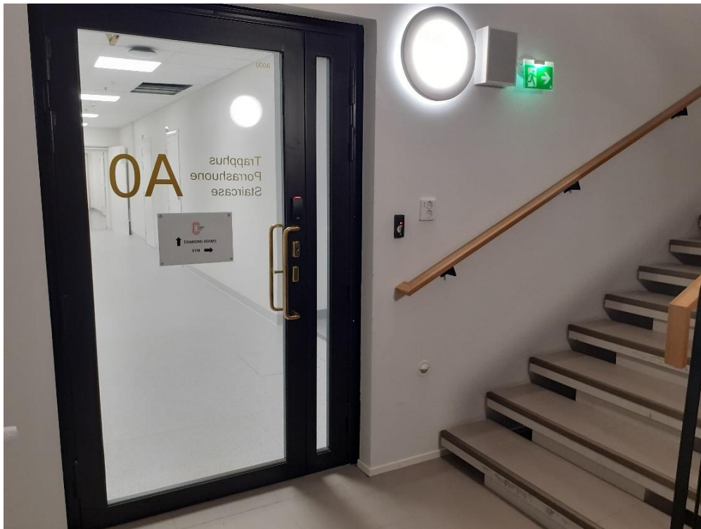
KUVA 6: Ovi kellarin aulatilaan
