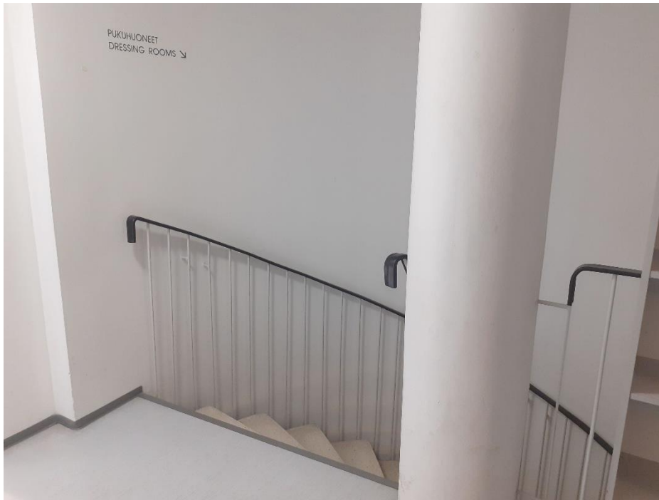
KUVA 7: Portaat alakertaan väliovelta katsottuna
