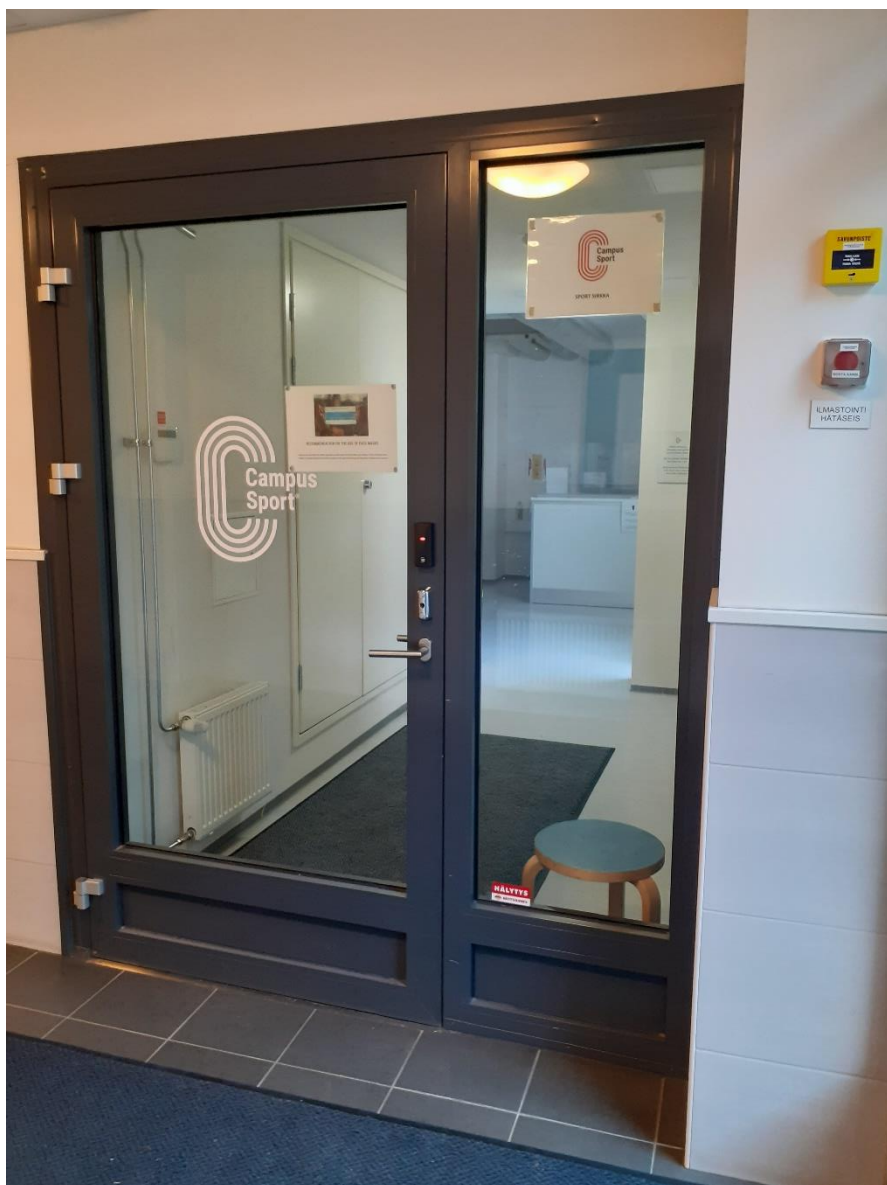
KUVA 2: Väliovi ulko-ovelta katsottuna
