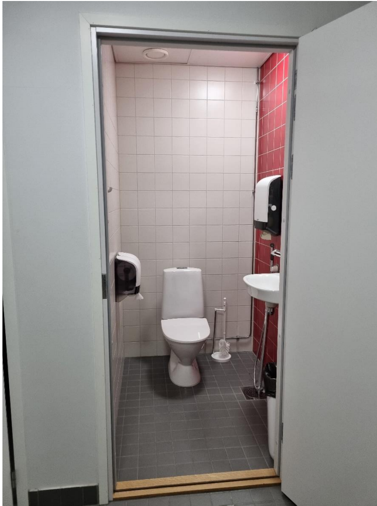
KUVA 5: Pukuhuoneen WC. Aulan WC:n sisustus on samanlainen.
