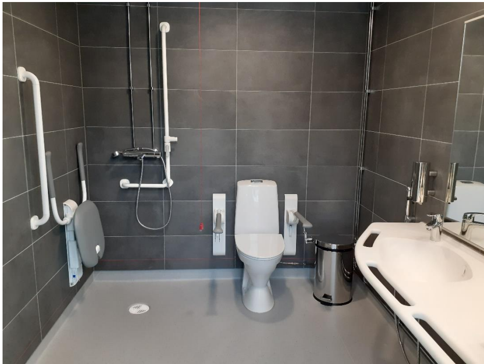
KUVA 3: Esteetön sukupuolineutraali WC ja yksilöpukuhuone
